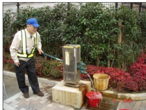
شکل ۴: نمونه پمپ دستی استحصال آب از مخازن زیرزمینی کم عمق برای استفاده در موقع بحران
